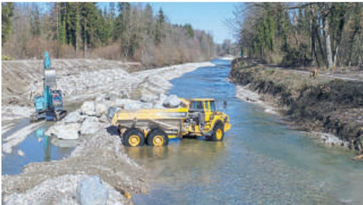
Noch im Februar 2020 sieht man, wie Schritt für Schritt die alten Eisenbahnschienenreste durch Natursteinblöcke zur Ufersicherung ersetzt werden.
