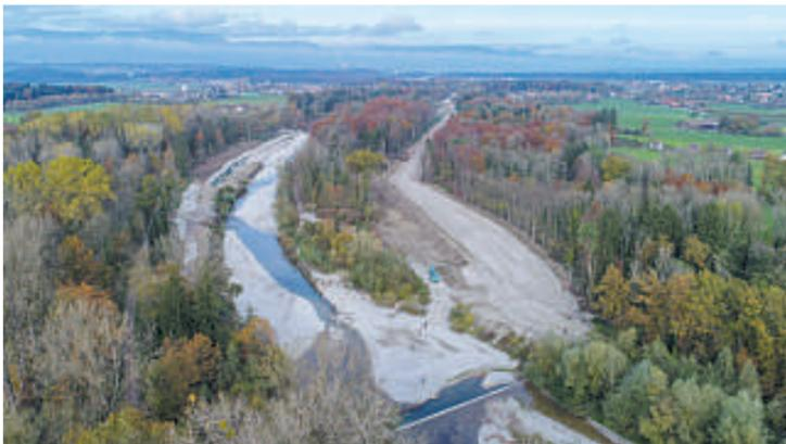
Im November 2019 nimmt der neue, breite Damm, der in der Folge auf eine Höhe von 2 Metern aufgeschüttet wird, erste sichtbare Formen an.
